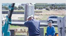
7 墓石の解体・処分
